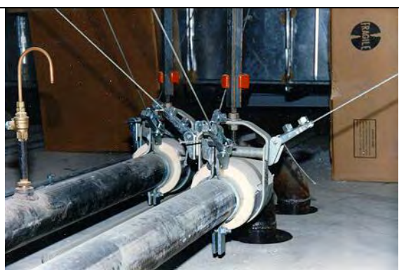
חיבור אורכי על ידי כבל בקצה קטע קו
